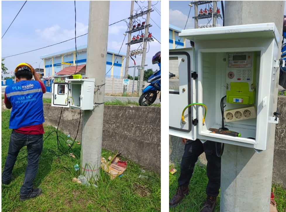
Gambar 8. Instalasi Listrik Oleh Tim PLN
