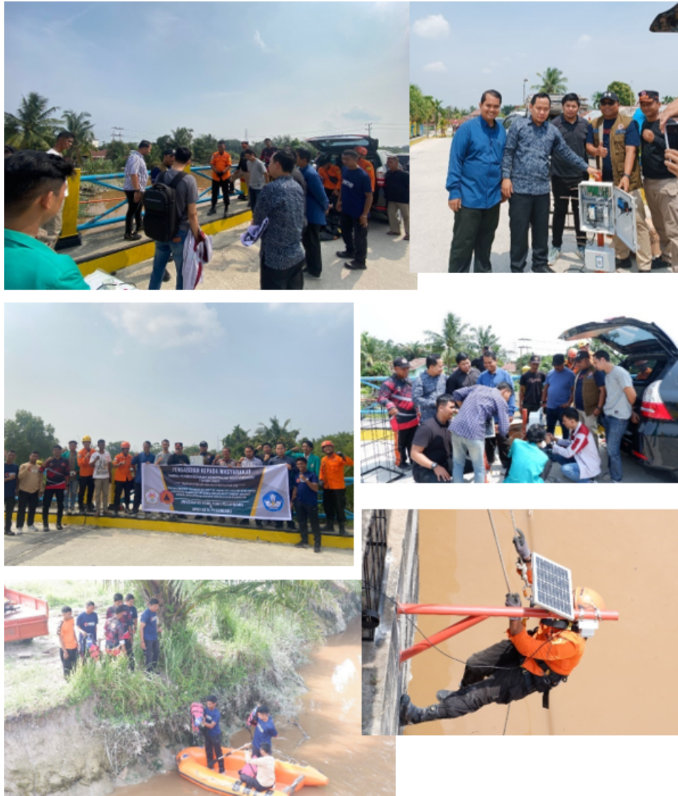
Gambar 9. Kegiatan pemasangan alat monitoring ketinggian permukaan air
